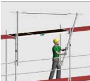
Bild 39: Montage des MSG im Aufstiegsfeld
