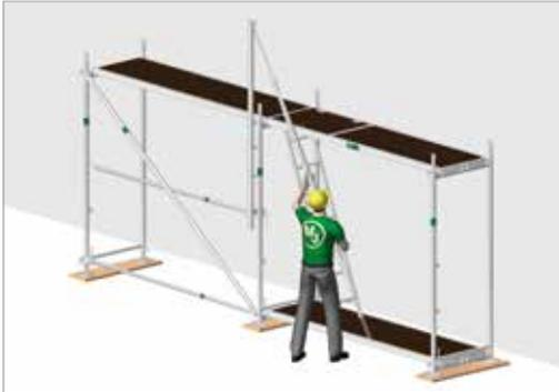
Bild 88: Einhängen des MSG-Geländerholms am ersten MSG-Pfosten
