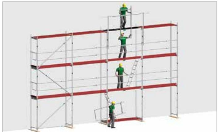
Bild 40: Montage des Aufstiegsfeldes im Schutze des MSG
