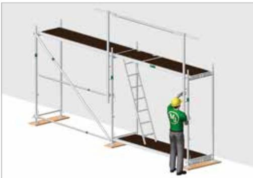
Bild 90: Montage des zweiten MSG-Pfostens
